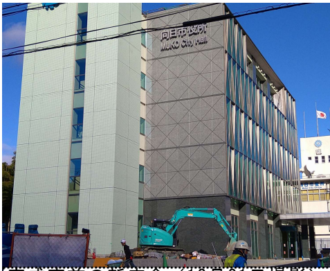
完成直前の新庁舎。(12月21日撮影)
