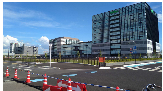
完成した日本電産C棟(北面)
